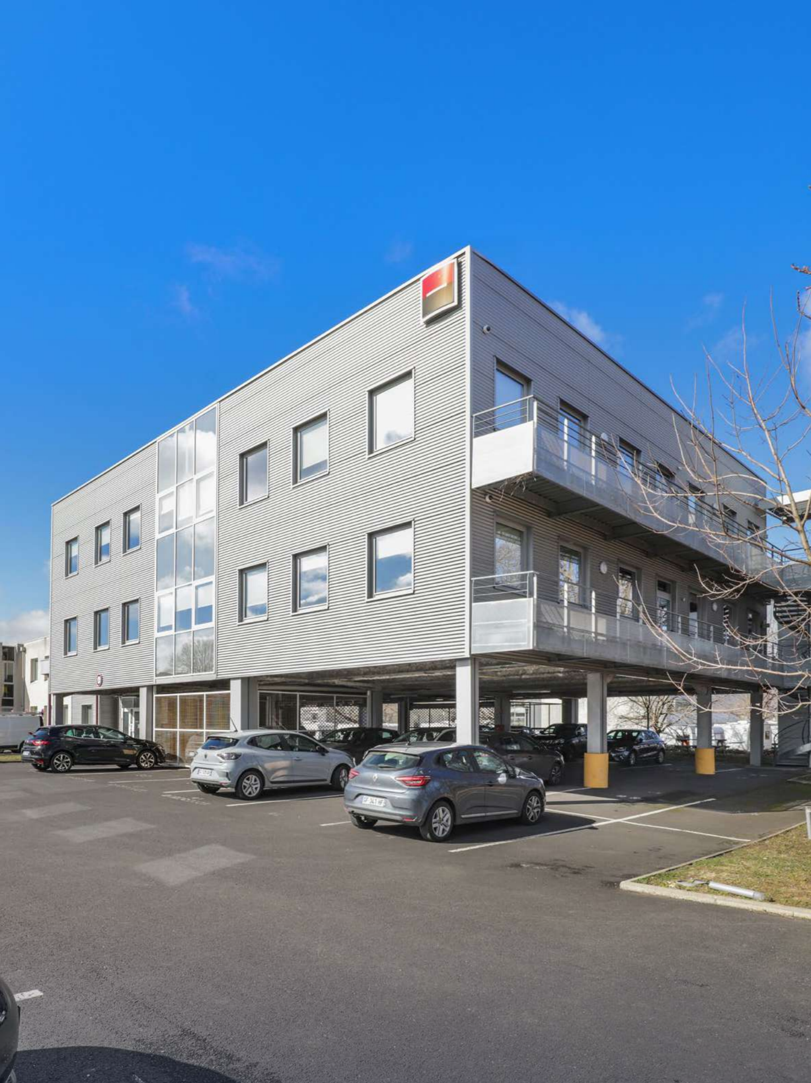
Bureaux à Clermont-Ferrand "Jean Claret", acquis en septembre 2022
