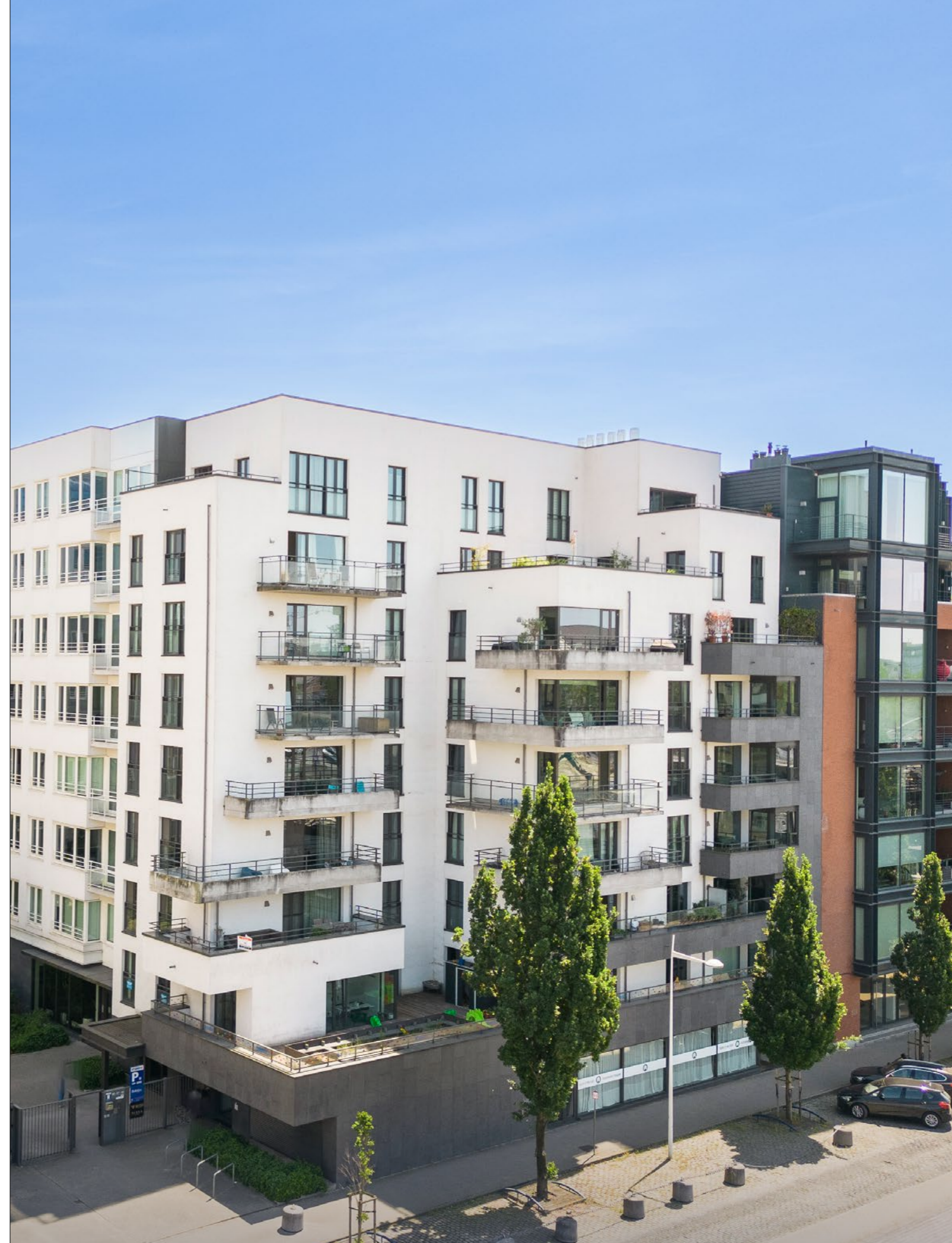
Crèche à Bruxelles "Quai des Péniches" (BE), acquis en décembre 2021
